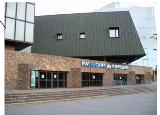
Façade de la Patinoire Cours du Maréchal Juin
